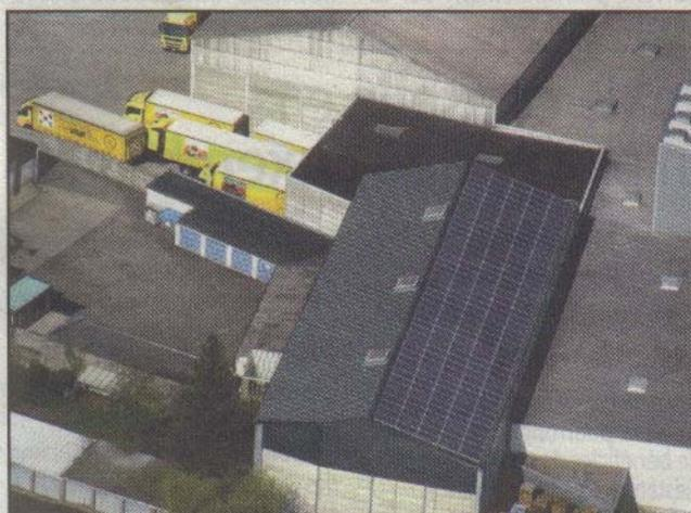
*Les 350 m<sup>2</sup> de panneaux photovoltaïques représentent 15% de la surface de toiture des installations de la Scar à Herve. Ils produiront l'équivalent de 3 à 4% de la consommation annuelle d'électricité de la coopérative*
